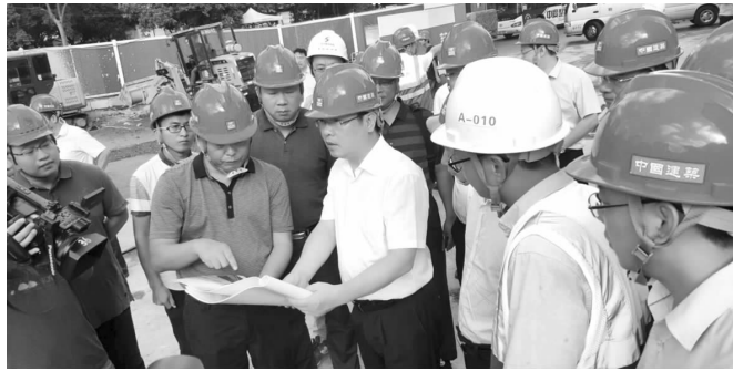
图为市领导一行在迎宾大道、湖滨西路等多个施工现场实地调研
